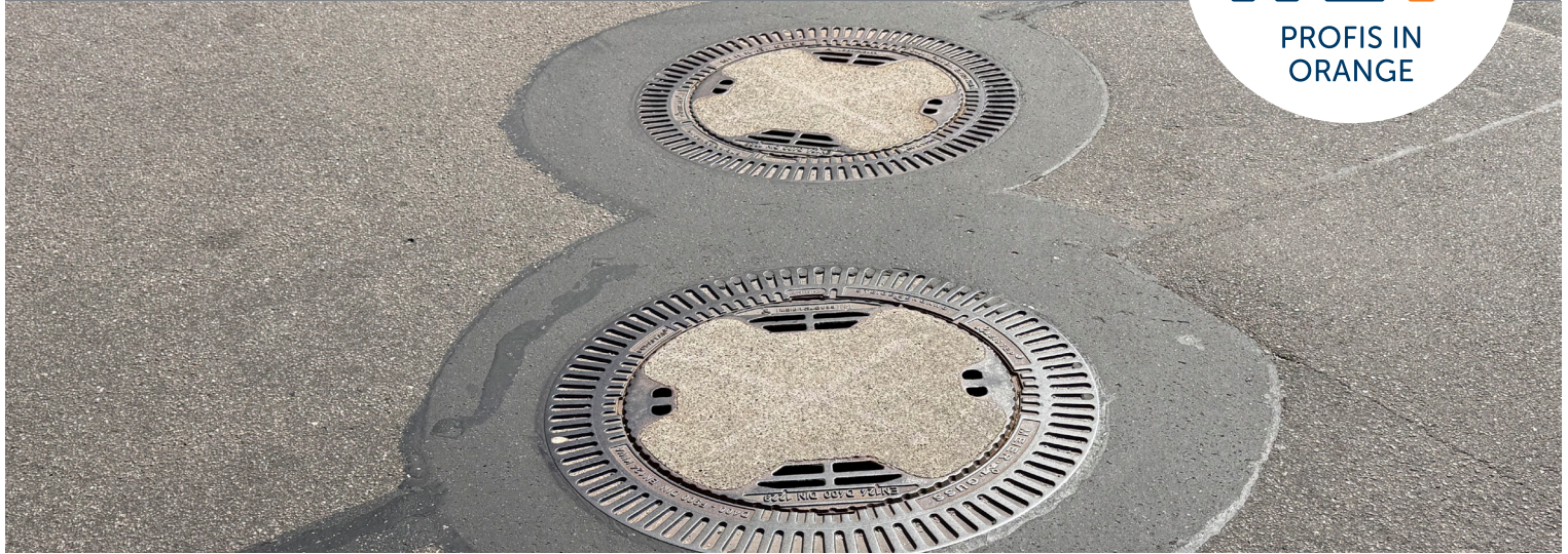
Inhouse-Vergabe am Beispiel einer Schachtkopfsanierung
