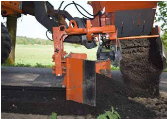
Material aufbringen und verteilen in einem Arbeitsschritt
