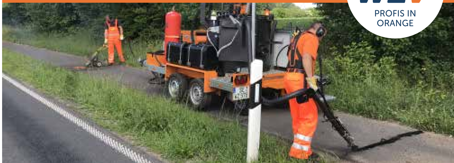
Zeitgleiches Ausblasen und Auffüllen des Risses
