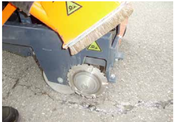
Fugenfräse im Einsatz
