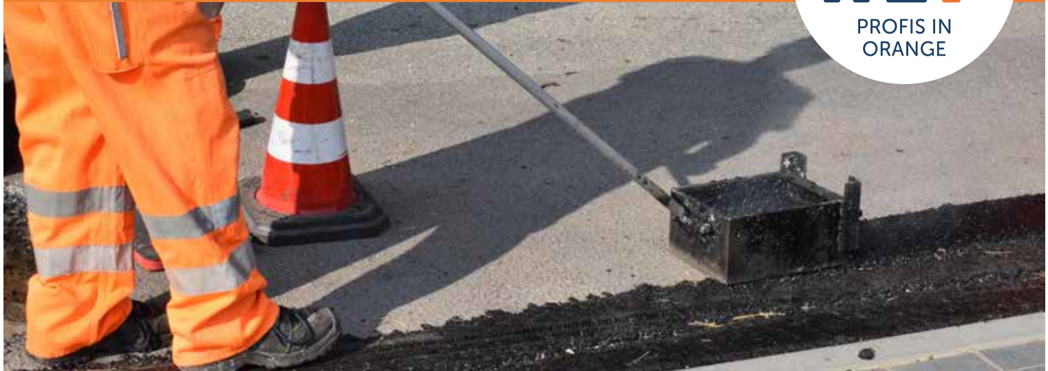
Aufbringung von Gussasphalt
