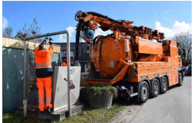
Kanalspüler bei der Reinigung einer Pumpstation
