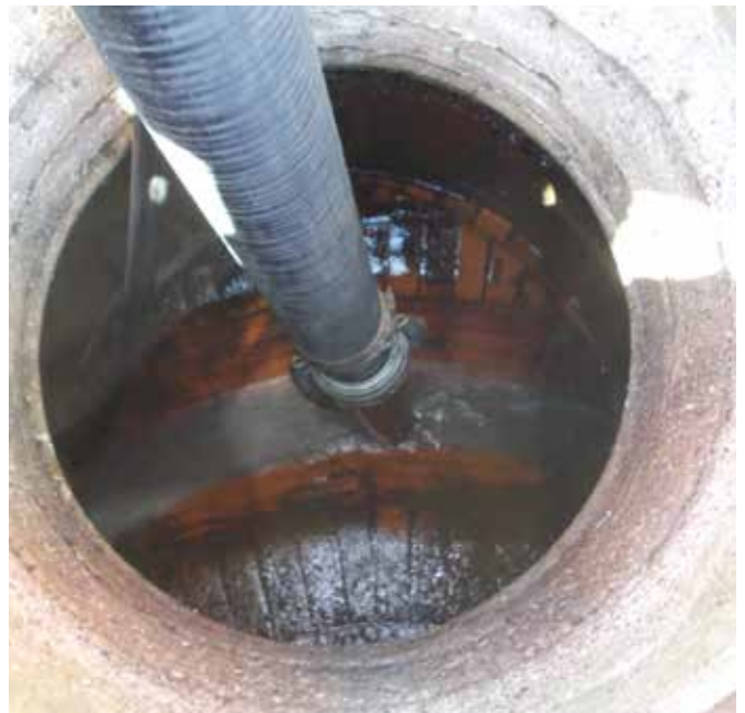
Blick von oben in den Schacht
