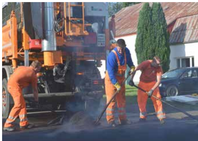
Dosierung und Positionierung des Asphaltgemisches
