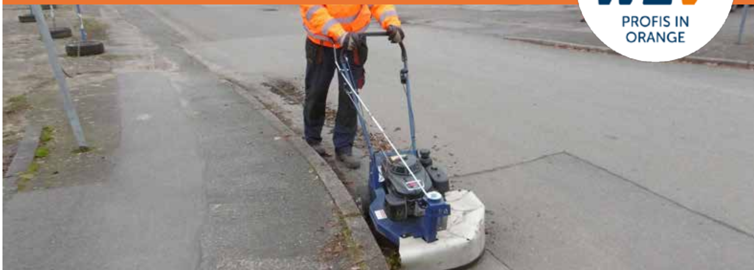
Reinigung des Hochbordes (ca. 500 Meter pro Tag)
