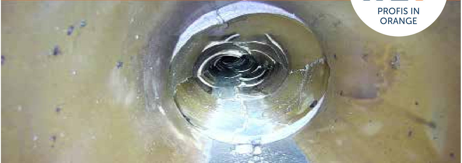
Vergleichsweise ein Durchlass in der Gemeinde Neversdorf (Kreisstraße)
